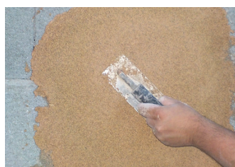
Pose sur parpaing ou brique
