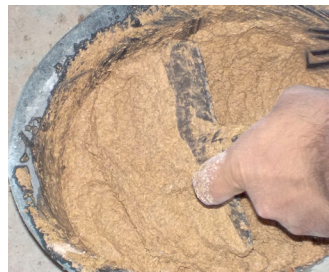
Mélange chaux colorée et roseau et ajout de 0,5l d'eau max
