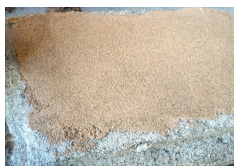
Pose sur béton de roseau
