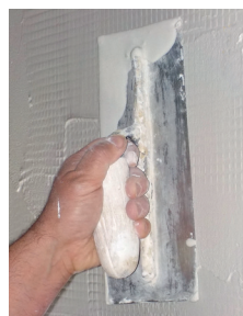
Mélange chaux colorée et roseau et ajout de 0,5l d'eau max
