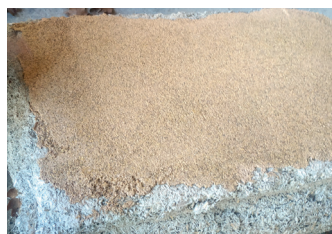
Pose sur béton de roseau
